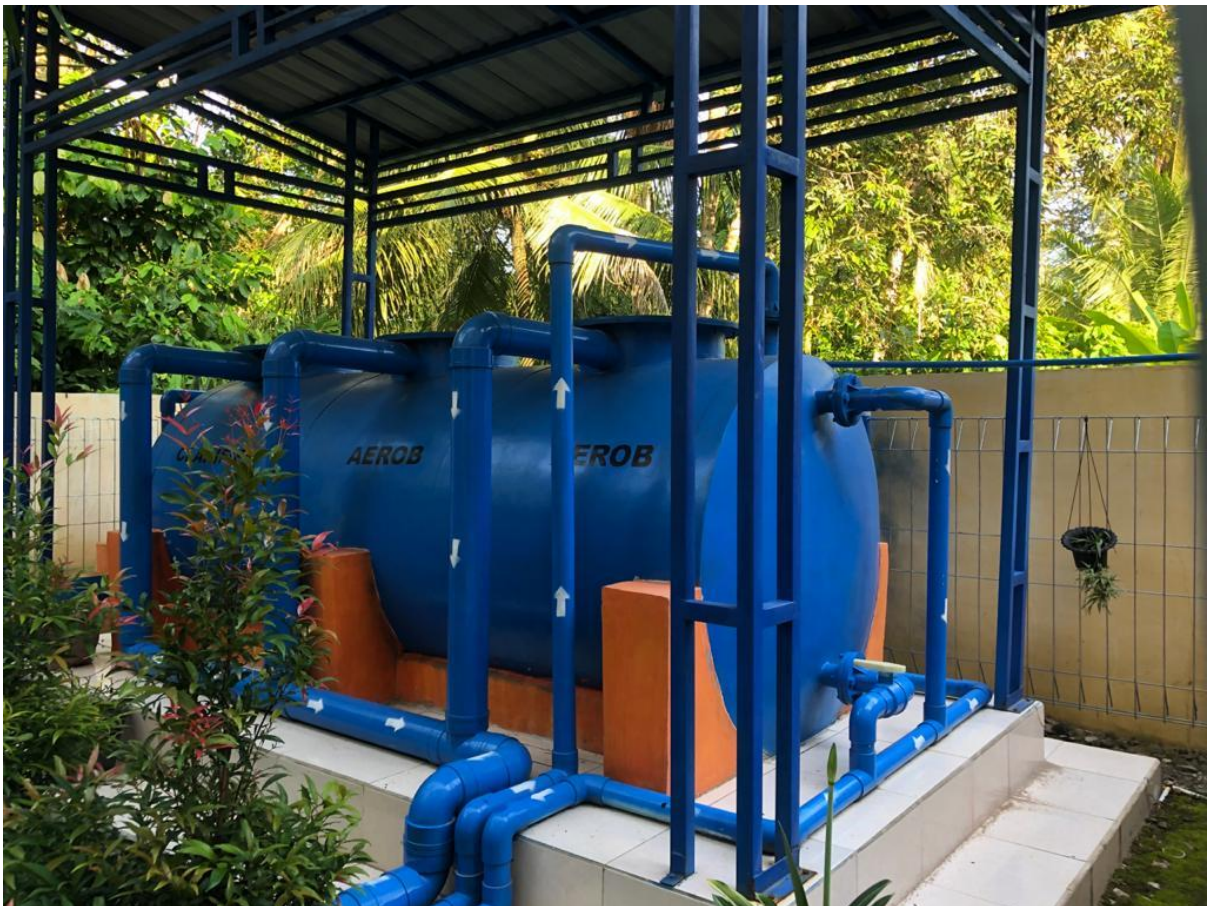
IPAL (instalasi pengolahan air Limbah)
